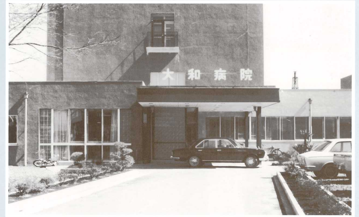
昭和45年3月 3階建病棟完成 （病床数182床）
