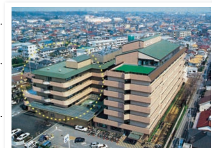
平成9年11月 介護老人保健施設 東大和ケアセンター完成
