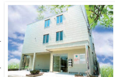
平成25年8月 在宅サポートセンター棟開設
